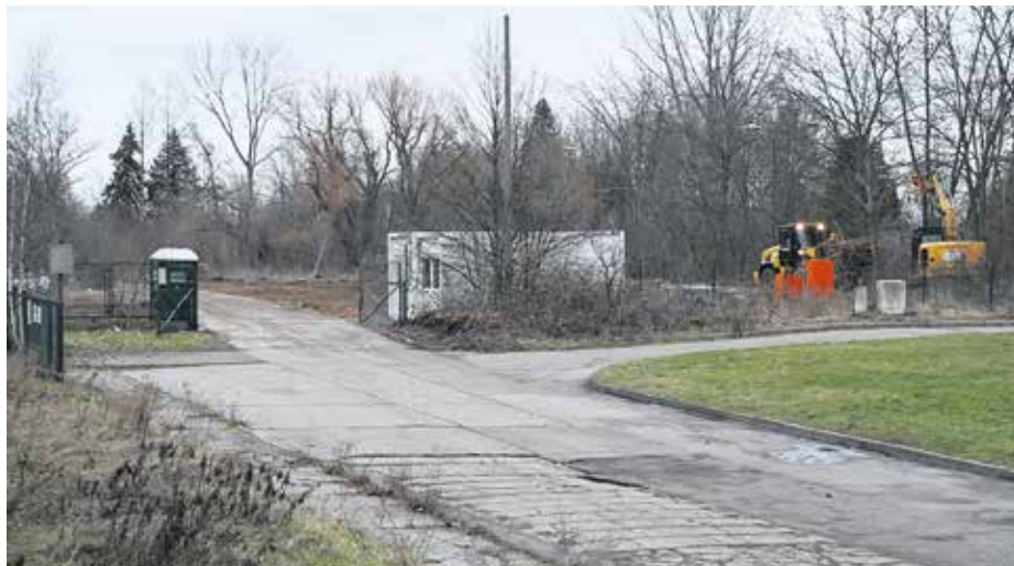
Mit den Arbeiten wurde bereits begonnen.
