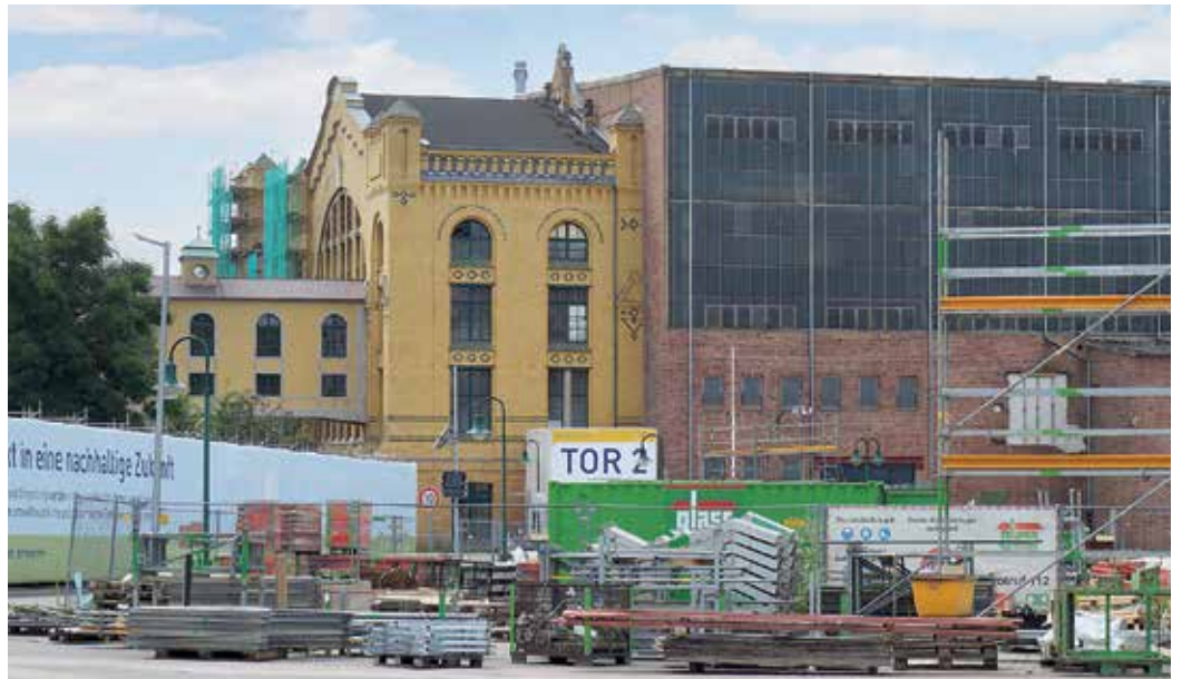
Blick auf die Großbaustelle des HKW Leipzig-Süd in der Bornaischen Straße.
