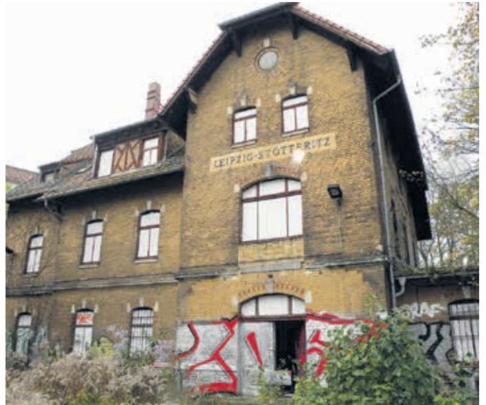
Wie eine Trutzburg behauptet sich der alte Stötteritzer Bahnhof.
