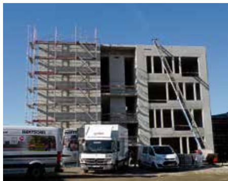
Rohbau für Oberschule steht ...
