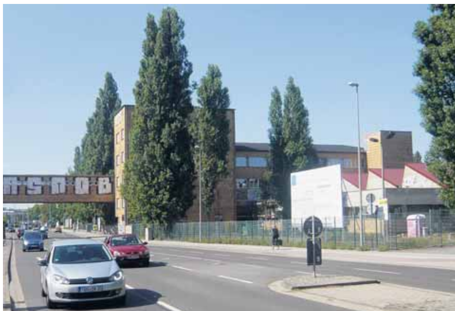
Blick auf den nördlichen Bereich des historischen Postbahnhofs.
