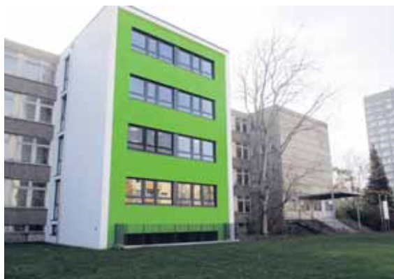
20. Schule mit neuem Anbau
